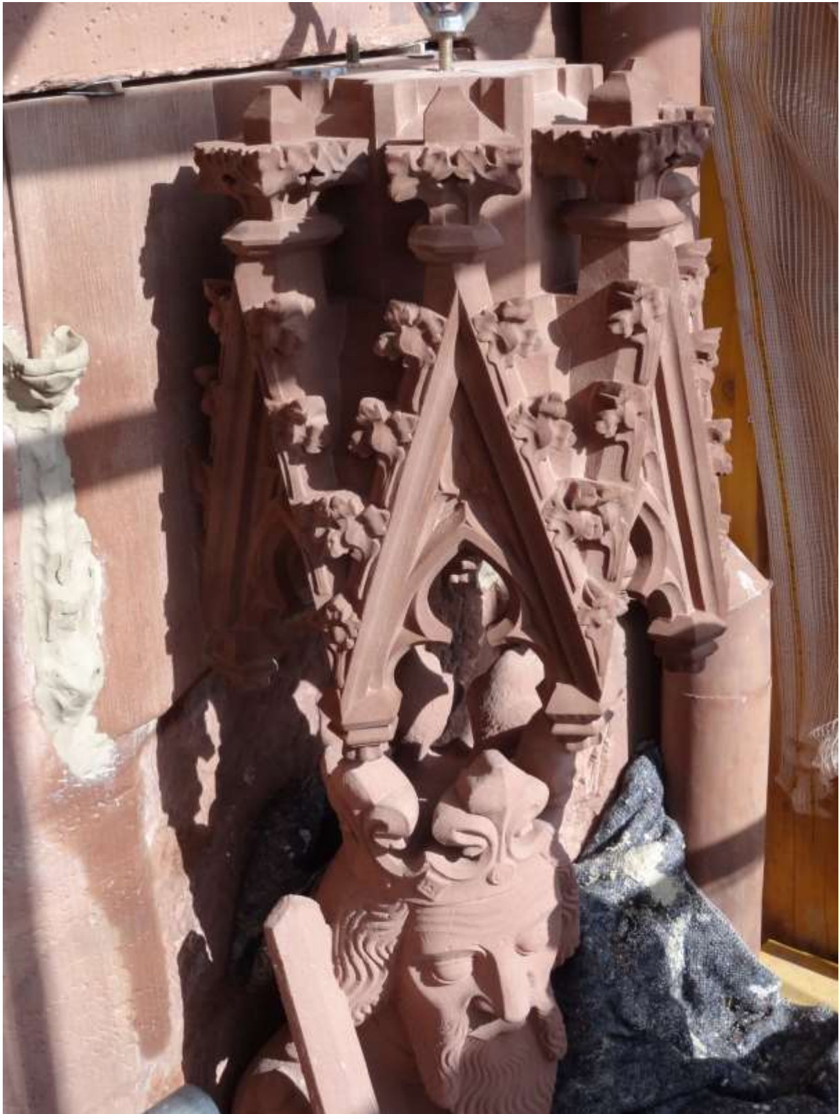
Der Baldachin wird mit Kalkmörtel vergossen, und wird so wieder eins mit dem Münster.
